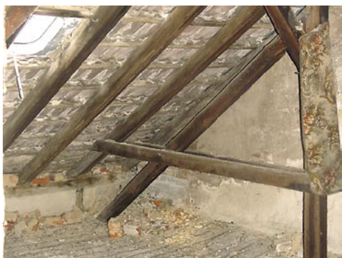
Detailansicht: Ist-Zustand im Dachgeschoss
