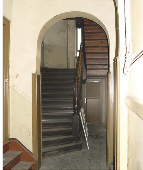
Blick ins Treppenhaus
